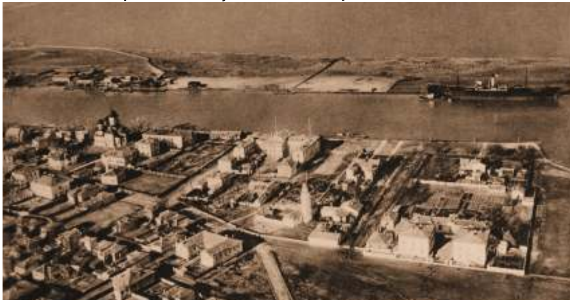
Clădirile din complexul C.E.D. și zona Portului franc
